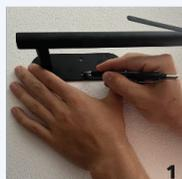
Positionieren Sie den Rollenhalter an der gewünschten Position und zeichnen Sie die Bohrlöcher an.
