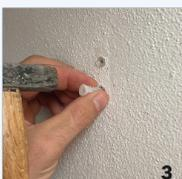
Setzen Sie die beiden Dübel in die Löcher ein und achten Sie darauf, dass sie nicht überstehen.
